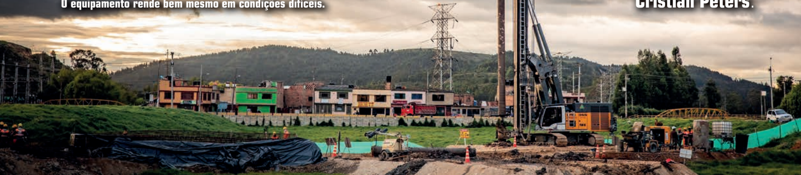
A Mincivil utiliza uma LRB 355 para instalar os pilares em Mosquera. O equipamento rende bem mesmo em condições difíceis.
