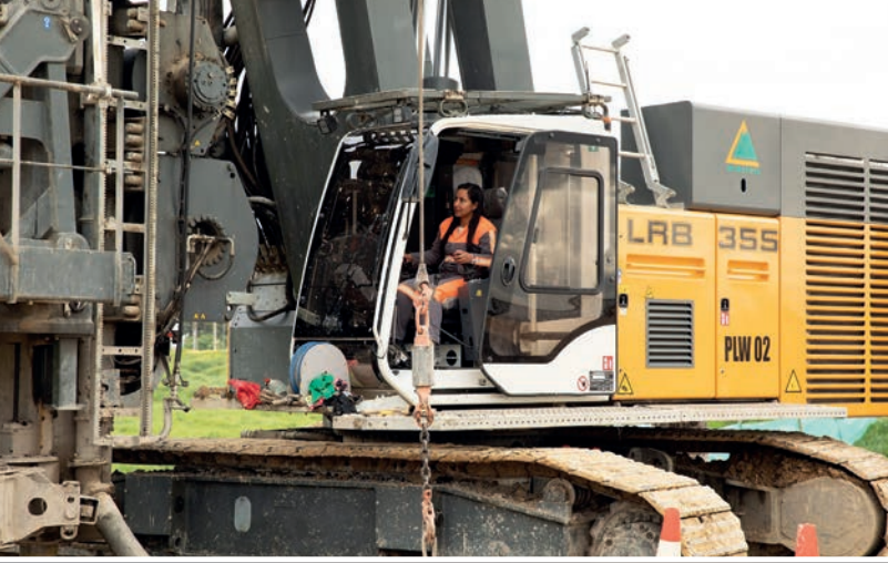
A Mincivil utiliza uma LRB 355 para instalar os pilares em Mosquera. O equipamento rende bem mesmo em condições difíceis.
