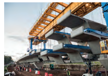
O viaduto ferroviário de Mitre é a primeira aplicação do equipamento na capital.
