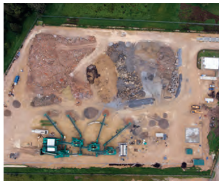
Planta de reciclagem de resíduos de construção e demolição da GRECO em Cota, perto de Bogotá.
