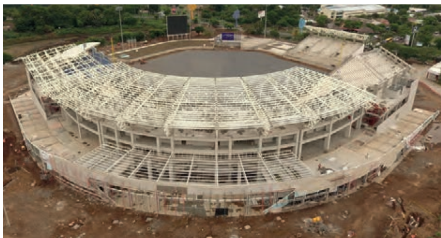
Obras como a do estádio de beisebol Dennis Martínez ativaram a construção na Nicarágua.
