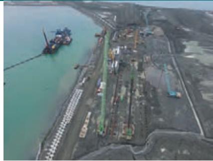
Vista aérea da obra no Terminal de Contêineres de Moin, na Costa Rica.
