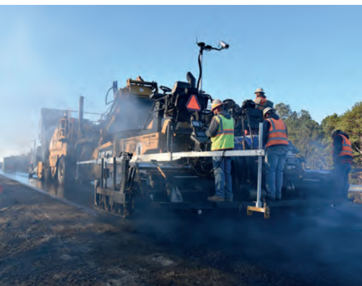
A câmera infravermelha mede e controla a temperatura do asfalto em pavimentadoras Caterpillar.
