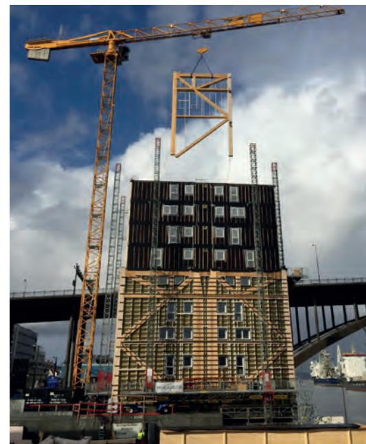
O marco de construção e os módulos de apartamentos de madeira são levantados usando um Potain MD365 na Noruega.
