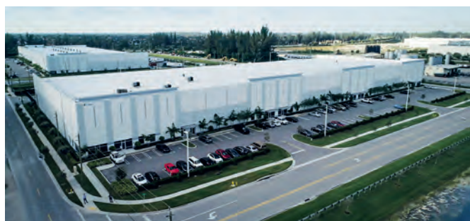
Dali sairão peças para equipamentos de linha amarela da marca.
