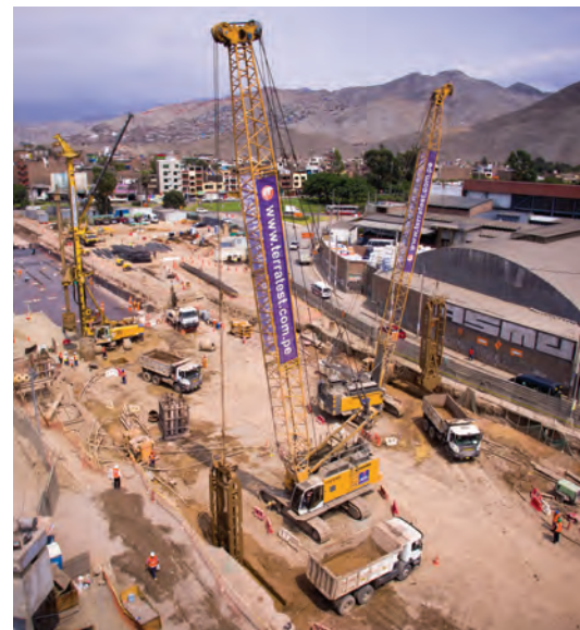
Paredes diafragma e pilares para a nova Linha 2 do Metrô de Lima, no Peru.
