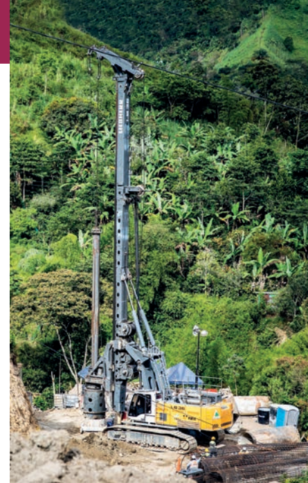
Em primeiro plano, a LB 36 da Liebherr em ação. Atrás, equipe se dedica à perfuração manual em área onde a máquina não pode acessar.
