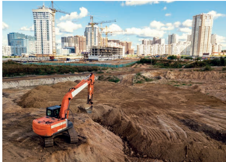
Relatório afirma que a construção continua sendo responsável por 39% do total de emissões de carbono no mundo.
