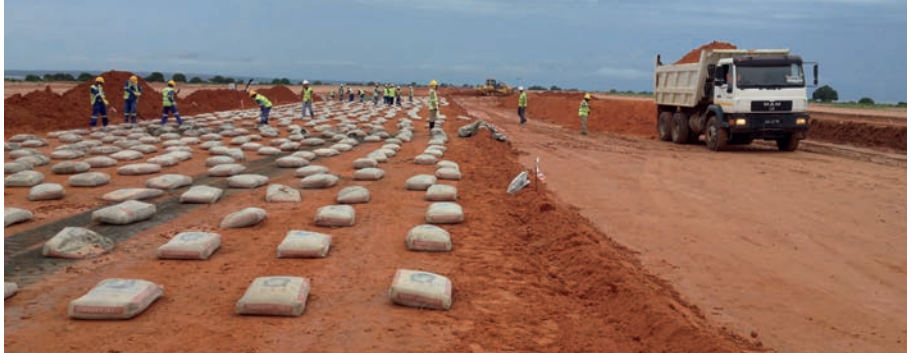
Uma das formas de executar a colocação do cimento para mistura direta no solo, se não houver veículos de distribuição.
