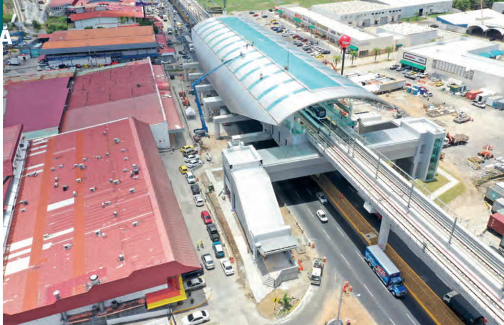
A ampliação da Linha 1 inclui uma estação terminal elevada na ala norte, que terá capacidade para 10 mil passageiros em hora de rush, e conexão com outros modais.
